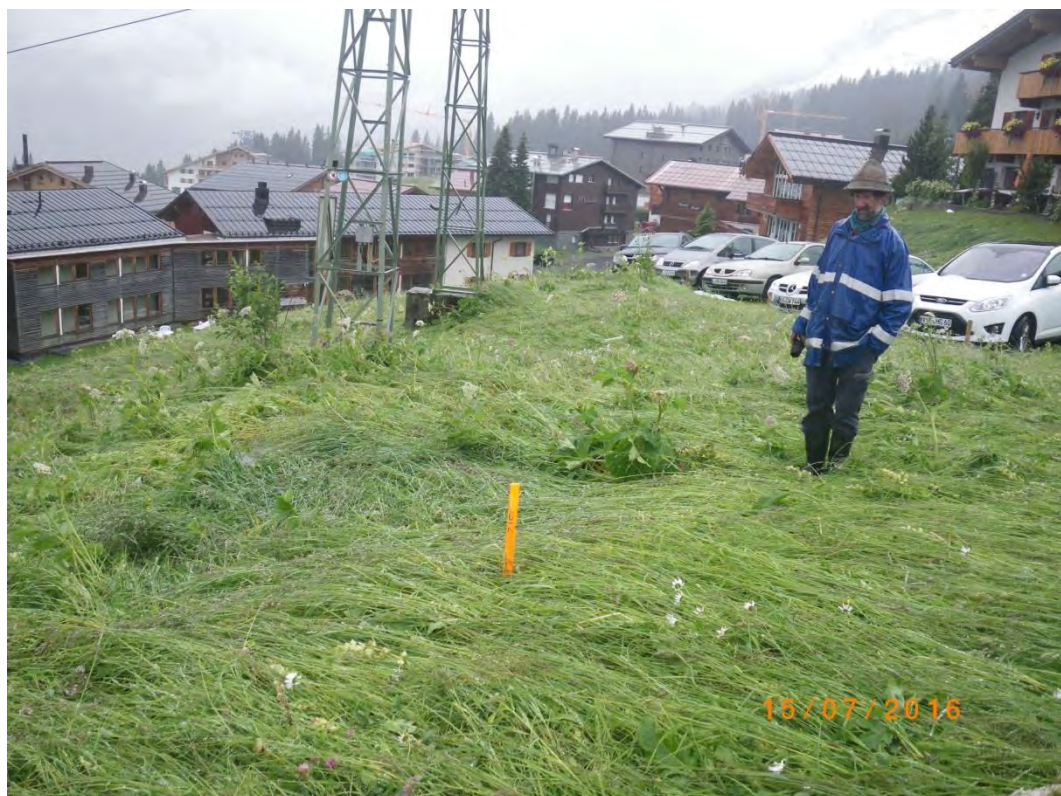
Bild 3: Standort der neuen Stütze 2
