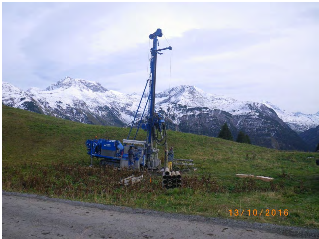
Bild 22: Bohrarbeiten am Standort der geplanten Stütze 11
