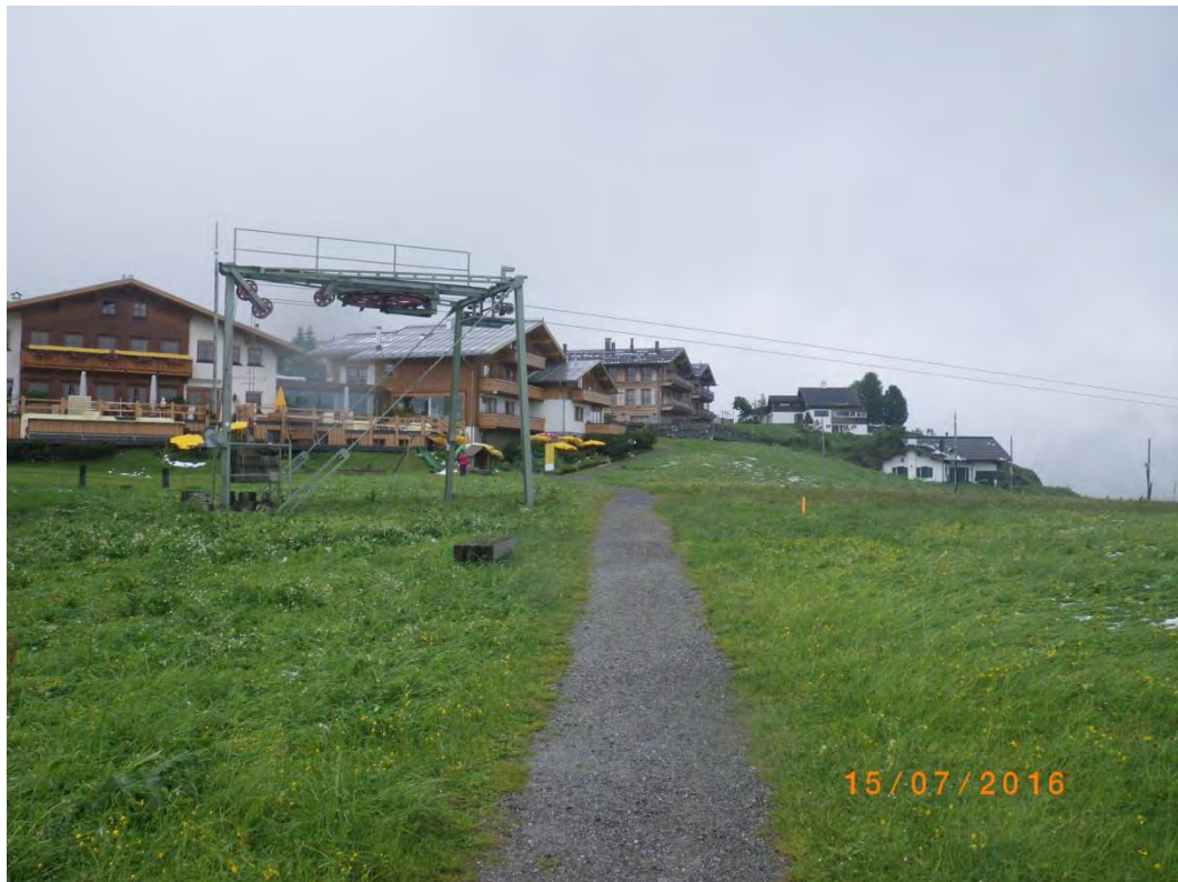
Bild 9: Ungefährer Standort Stütze 6 bei der Umlenkrolle des Schleppliftes
