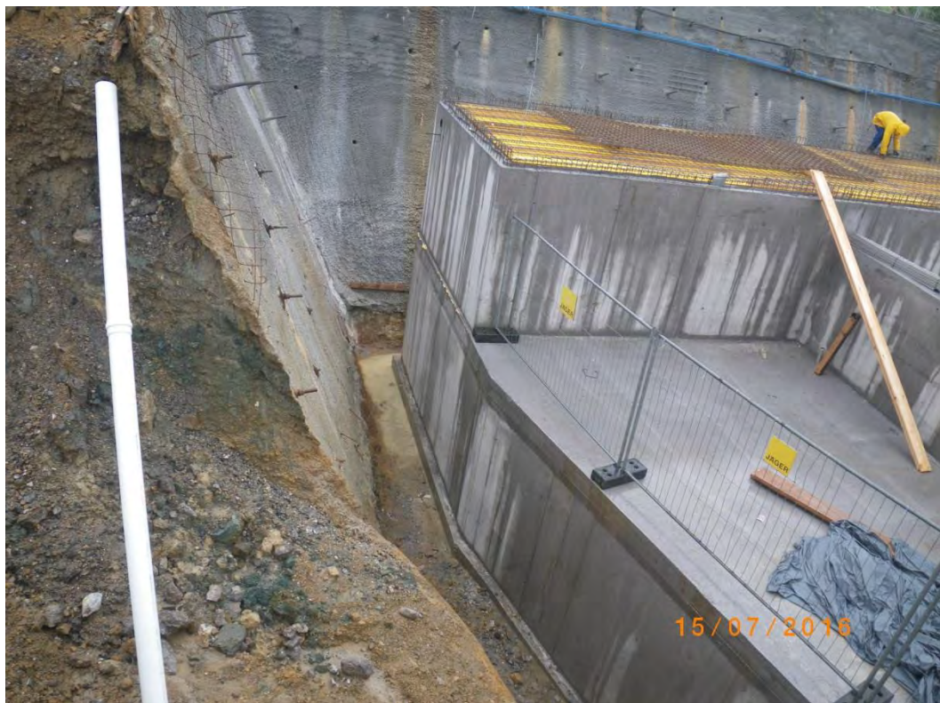
Bild 2: Baugrube im Sommer 2016 direkt ostseitig der neuen Talstation
