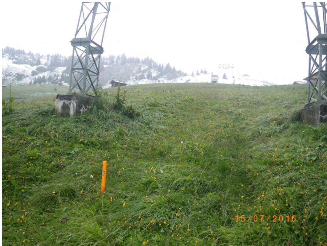
Bild 7: Standort der neuen Stütze 4 genau in der derzeitigen Schlepliftrasse
