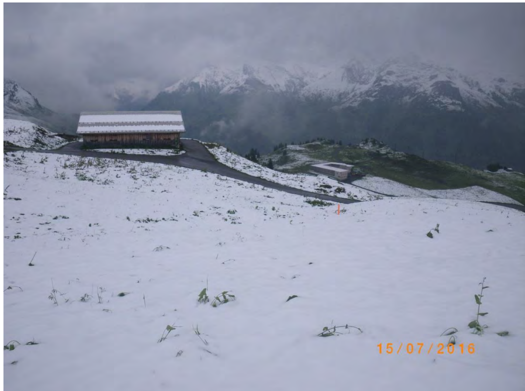
Bild 18: Blick zur geplanten Stütze 10 oberhalb der Grubenalpe
