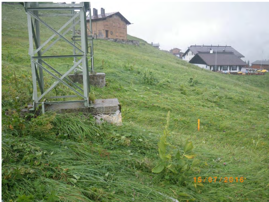
Bild 6: Standort der neuen Stütze 4 talseitig des bestehenden Stehers
