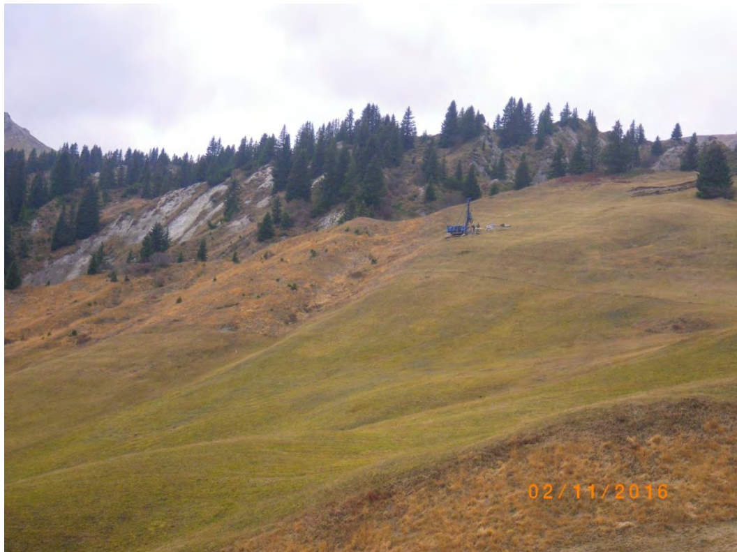
Bild 15: Bohrarbeiten am Standort der geplanten Stütze 8
