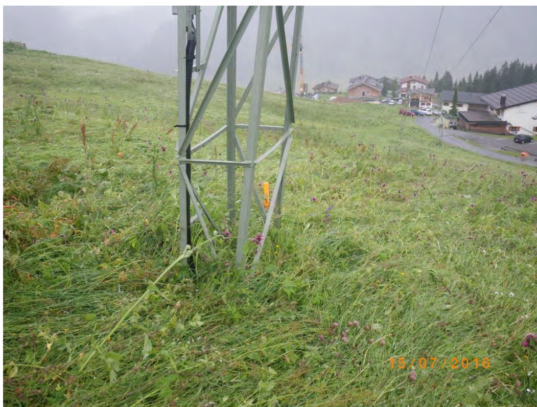
Bild 4: Standort der neuen Stütze 3 talseitig des bestehenden Stehers
